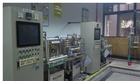
熱交換實驗裝置
